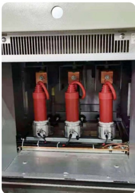
智能避雷器安装在客户变电站开关柜内实物照片见上图
