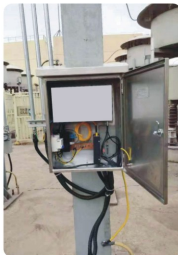
监测端子箱及便携式避雷器绝缘检测设备
