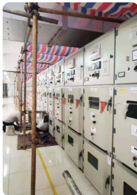
智能避雷器安装在客户变电站开关柜内实物照片见上图
